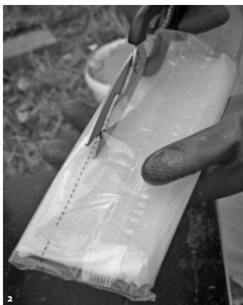
2 Aufschneiden der Kunststoffbeutel entlang der Markierung
